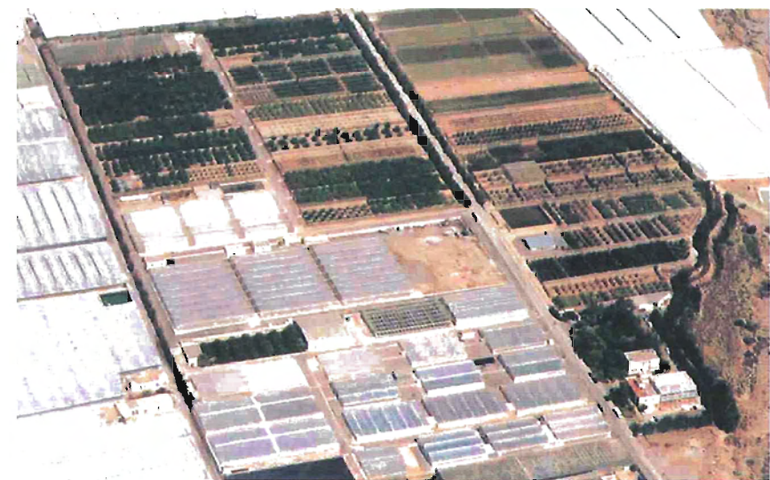
Figura 4 VISTA AÉREA DE LA ESTACIÓN EXPERIMENTAL DE LA FUNDACIÓN CAJAMAR
